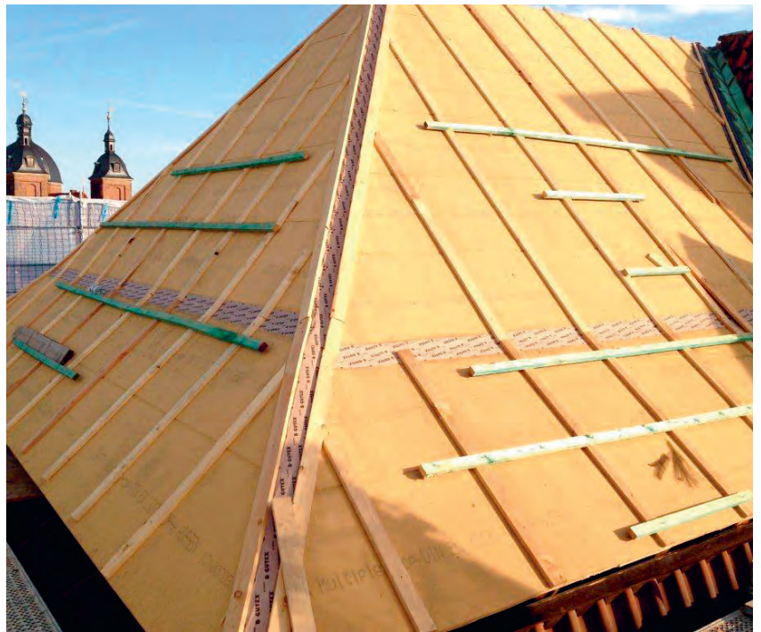
7 Gutex Multiplex-top, als Unterdach ausgeführt. Foto: Kleinwechter & Bröker GmbH
