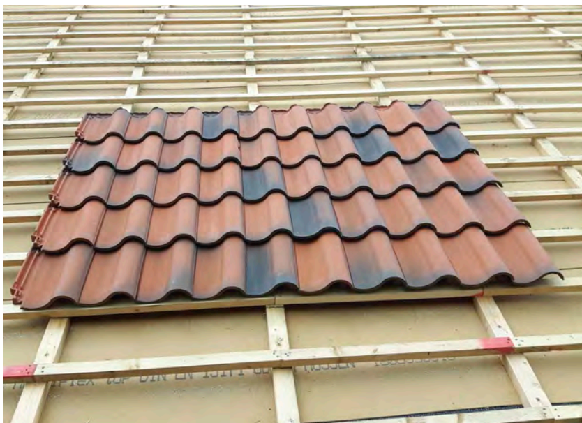
Auf der Vorbürg wurde ein regensicheres und winddichtes Unterdach mit GUTEX Holzfaserdämmplatten aufgebracht. Extra für dieses Objekt gebrannt wurden die Hohlalzfalziegel. Foto: Kleinwechter & Bröker GmbH
