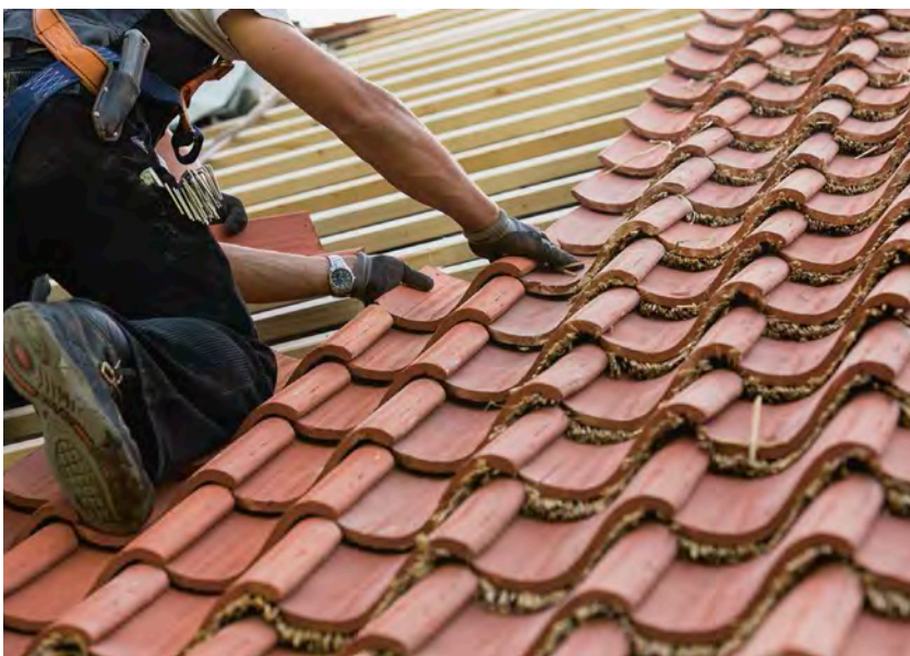
Dachziegel aus traditionellem Kohlebrand – die Eindeckung erfolgte mit Strohdoggen auf der Hauptburg. Foto: Kleinwechter & Bröker GmbH
